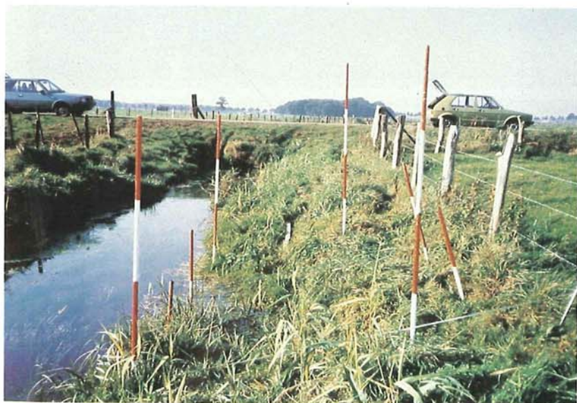
Detail aantasting lage oever. Op de voorgrond is de oorspronkelijke taludhelling met een meetband aangegeven.
