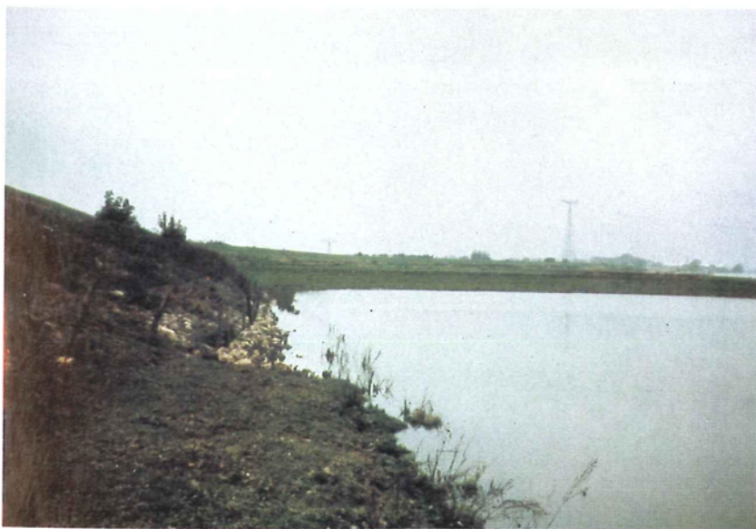
Hersteld basalttalud: detail
