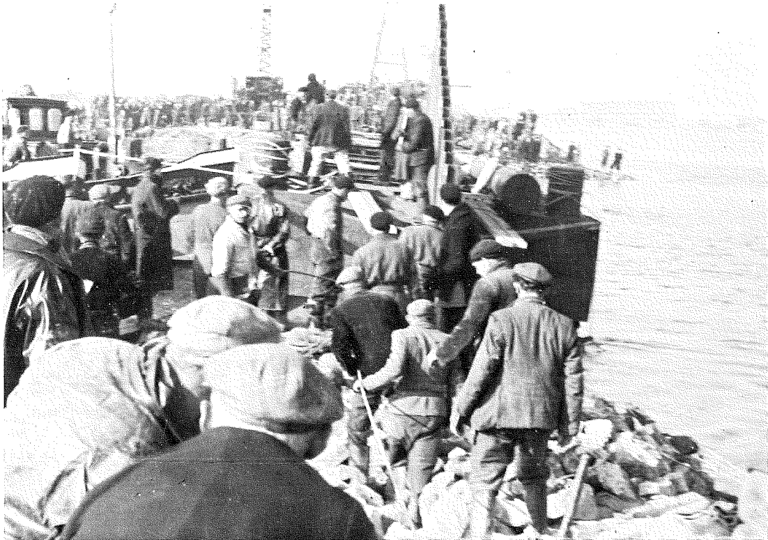
Dichten van het stroomgat in de Oudenhoornse zeedijk – Foto D. van Delden.
