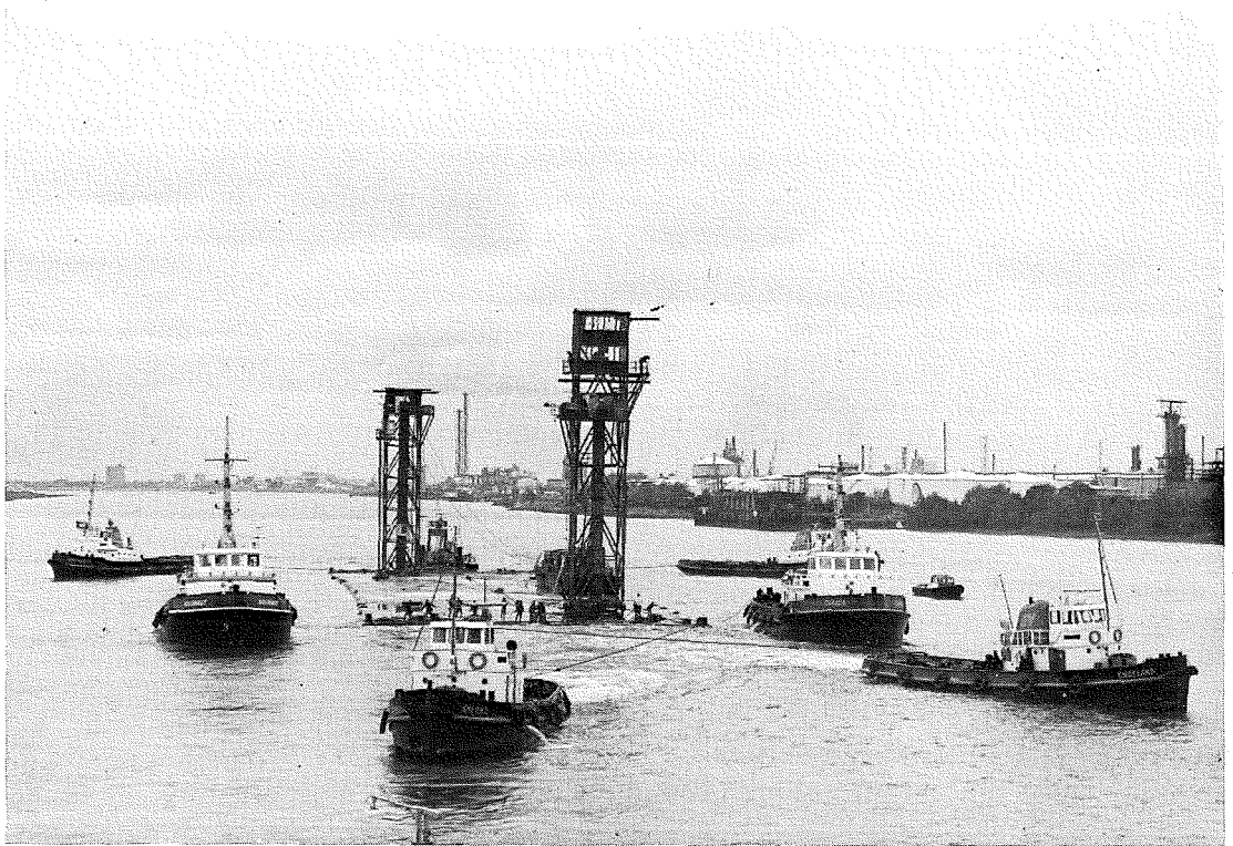
Eén van de vijf tunnel-segmenten wordt met véél pk's naar de afzinkplaats gesleept om de Botlek-tunnel te vormen – Foto A. Keller.
