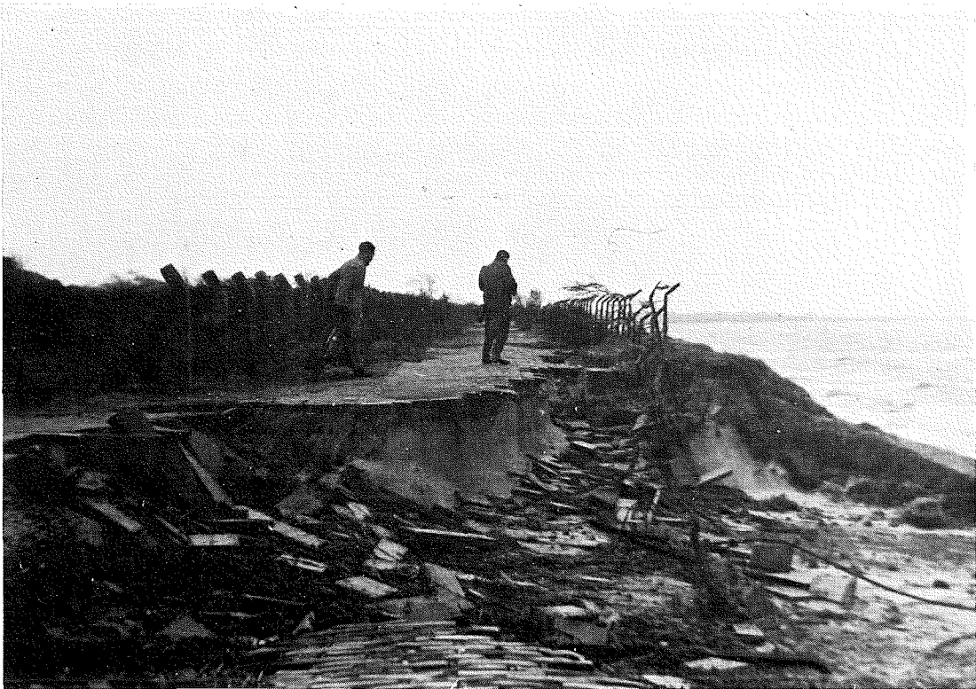
Afslag en vernielingen aan de boulevard van Oostvoorne – Foto D. van Delden.
