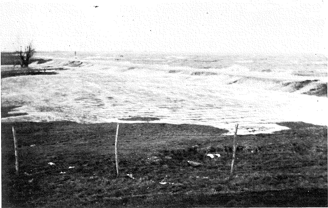
Stroomgat in de St aardijk op Rozenburg; 1500 ha land loopt onder water – Foto J. Bergwerff.
