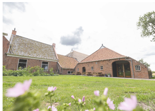
Shed of farm 'Maarhuizen' - source: Bouwgroep Dijkstra Draisma
