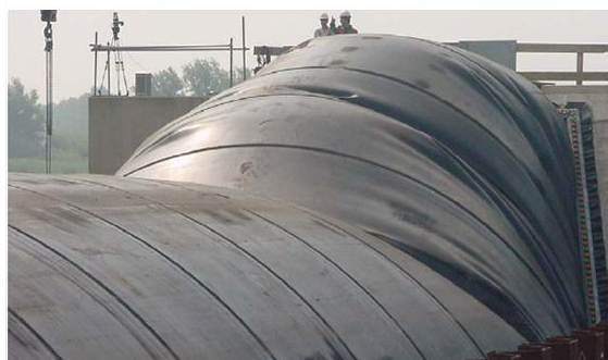
Figure 46: Folds in Ramspol barrier (Photo: Bouwdienst Rijkswaterstaat).
