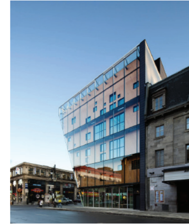
Quartier Des Spectacles / Ædifica
