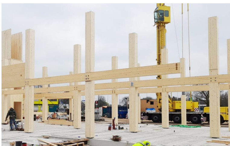
(a) Construction phase of the new Municipality Building of Krimpenerwaard. Adapted from Gemeente Krimpenerwaard (n.d.). https://www.krimpenerwaard.nl/nieuw-gemeentehuis
