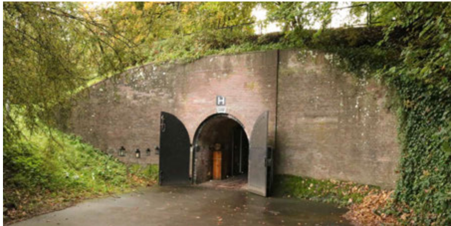
FIG. 4.56 Bunnik (NL), Fort bij Vechten. Flank battery H: façade (F. Marulo 2019)
