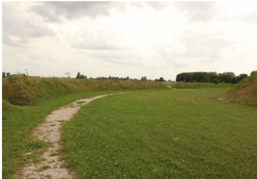
FIG. 4.65 Houten (NL), Lunet aan de Snel: pathway around the fort perimeter (design: Arc2 architecten) (F. Marulo 2019)
