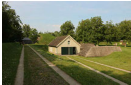
FIG. 4.92 Culemborg (NL), Werk aan het Spoen: the wooden shed replaced on the other side of the fort to realize the green amphitheatre (F. Marulo 2019)
