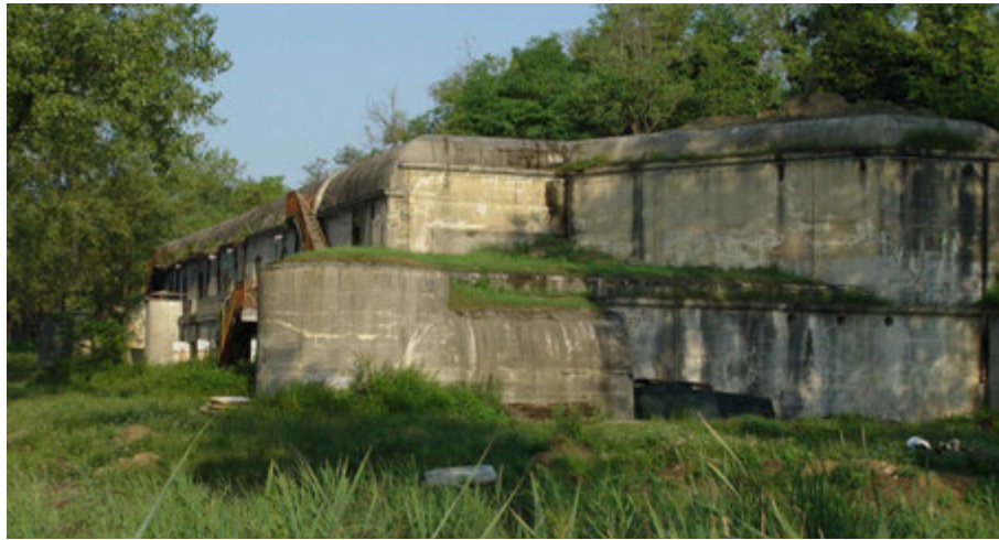
FIG. 5.87 Venice (IT), Forte Rossaroll: concrete battery, exterior (2006) (Archive Associazione dalla Guerra alla Pace)
