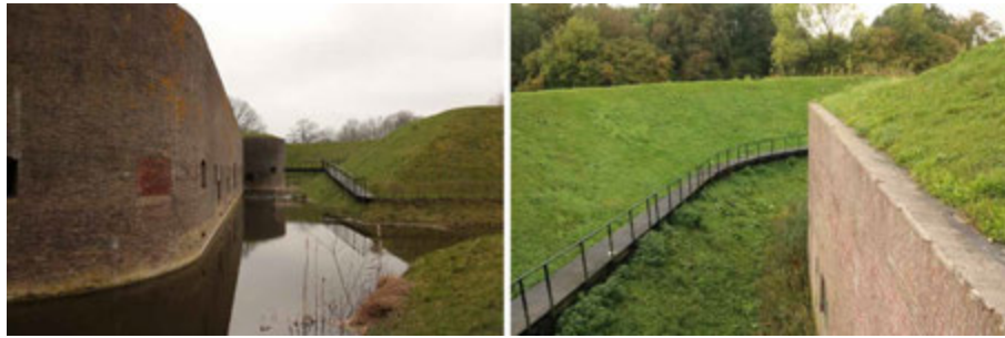
FIG. 4.43 Bunnik (NL), Fort bij Vechten. Central redoubt: external path (F. Marulo 2019)
