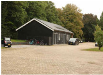
FIG. 4.102 Nieuwegein (NL), Batterijen aan de Overeindseweg: the shed trasformed into office space, exterior (F. Marulo 2021)
