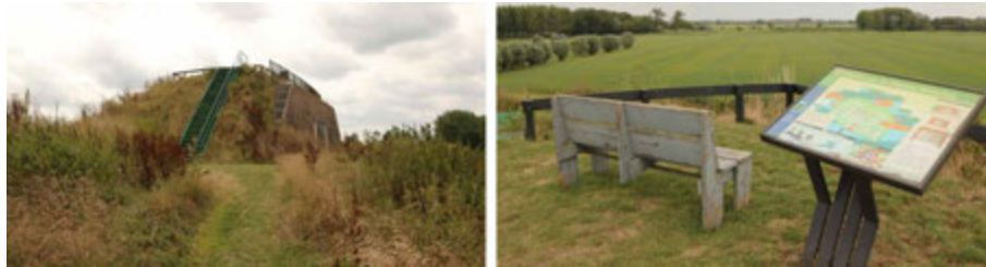
FIG. 4.82 Tull en 't Waal (NL), Werk aan de Waalse Wetering: panoramic point on top of the bombproof barracks (F. Marulo 2019)
