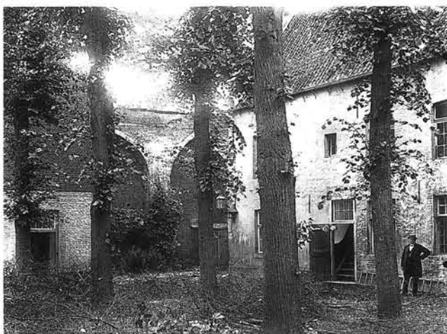
71-72 De cavaleriekazerne kort voor de sloop, opname waarschijnlijk 1916
