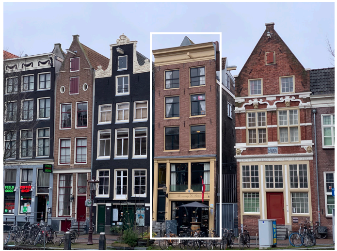
Figure 13: Oudezijds Voorburgwal 30. Own picture. For more pictures see appendix A.
