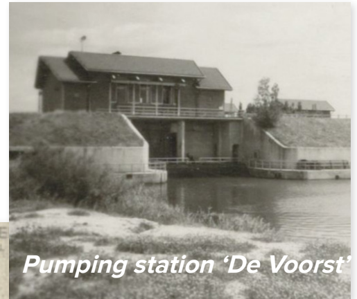
Fig 8: Pumping station De Voorst. Photo by Directie van de Wieringermeer, 1947 via https://www.hetflevolandsarchief.nl
