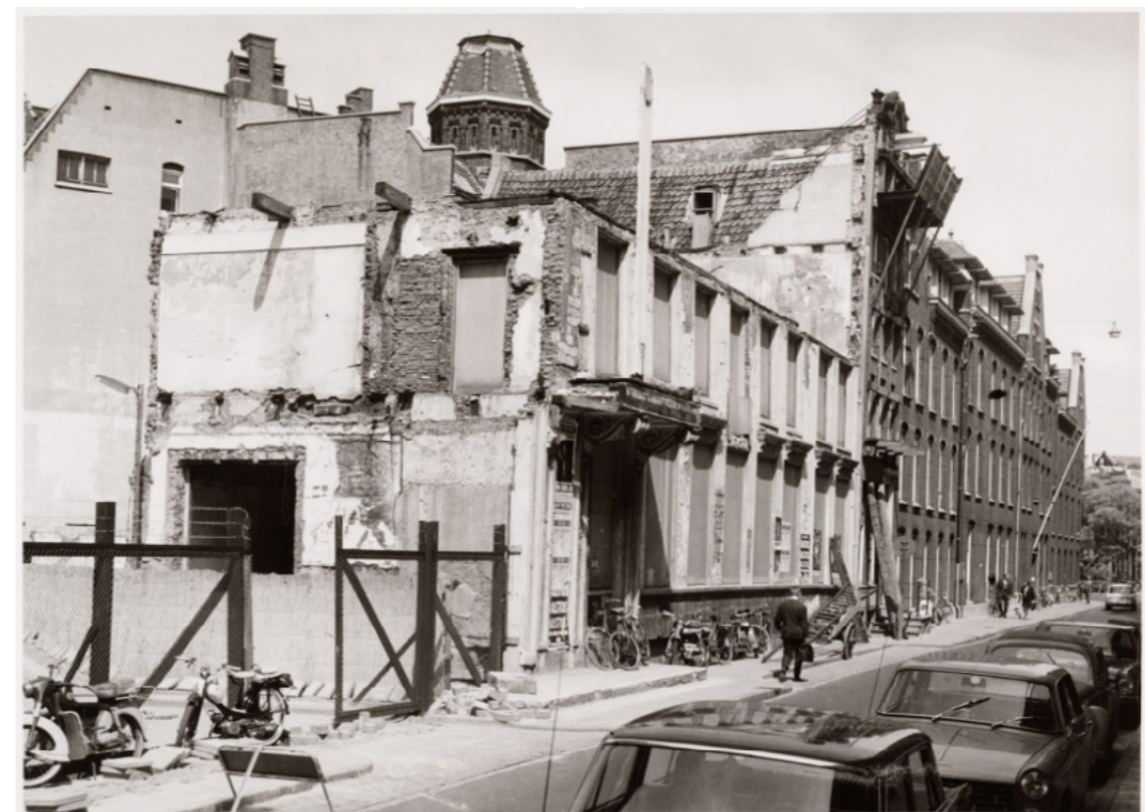
The demolition of Hotel des Pays Bas
