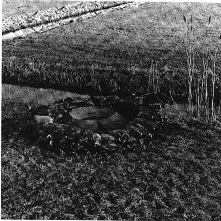
Figuur 6.2 Een krater bij Heesselt (na hoogwater) door piping veroorzaakt.
