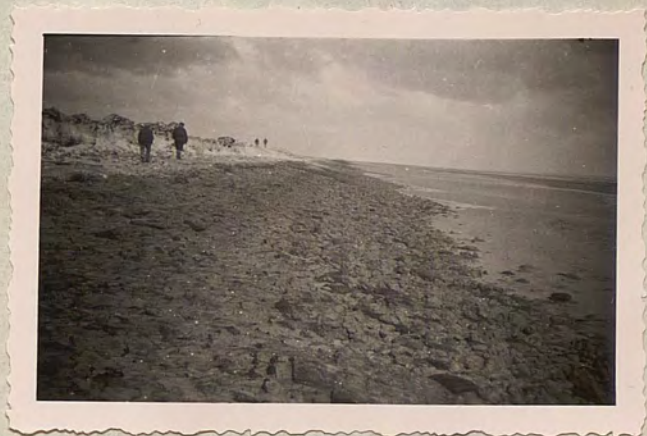
Weggeslagen bekrammate zoden en vernielde top.
