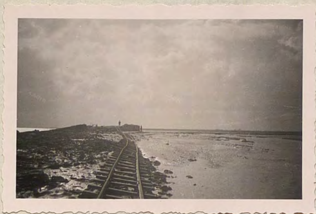
Dijkrest na vloed van 7 April. Binnenzijde.
