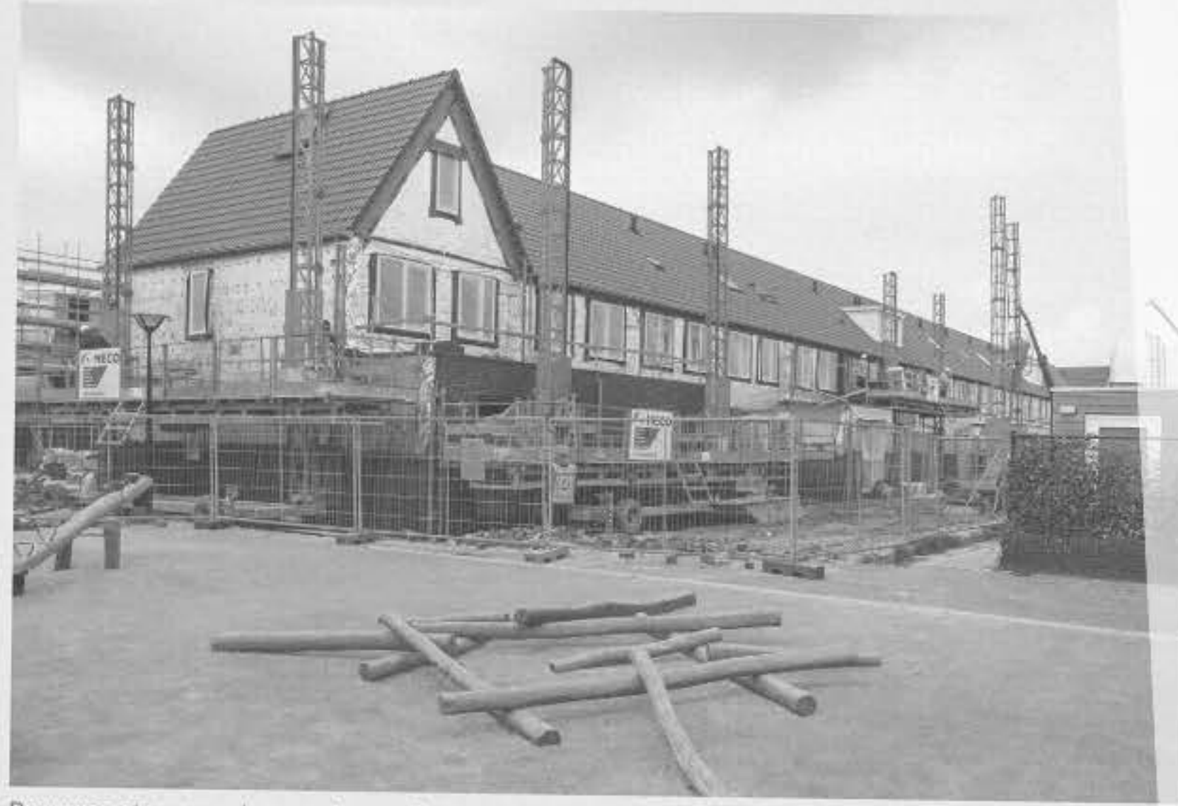
Bouw van nieuwe gasloze woningen. Op veertien grote woningbouwlocaties moeten tot aan 2040 honderdduizenden huizen verrijzen met goede verbindingen naar de stad. Foto: Hans van Rhoon/ANP
