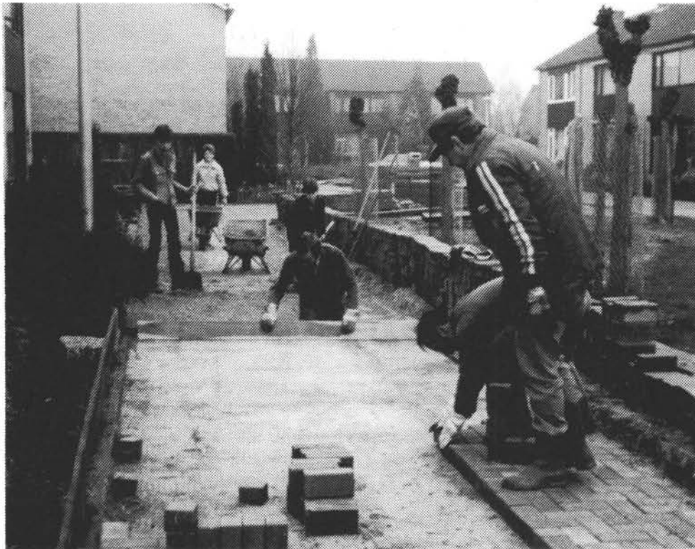
Figuur 13.6. Handlangerswerk door bewoners in Horst
