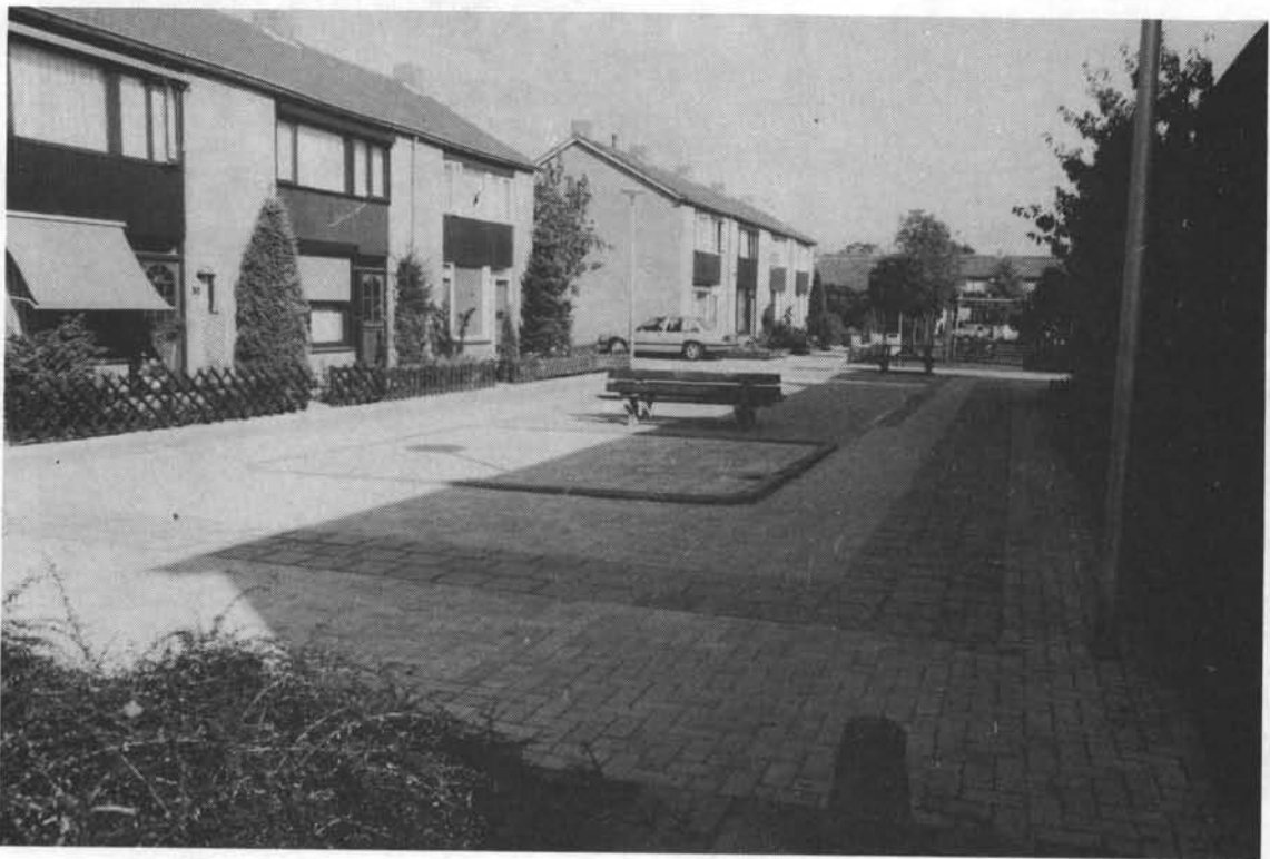
zelfwerkzaamheid van bewoners met betrekking tot verharding en straatmeubilair komt weinig voor; in Horst hebben bewoners onder andere lantaarnpalen verplaatst en meegewerkt bij het bestraten van de openbare ruimte
