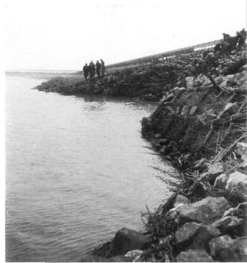
fig. 82. Herstel van de dijkval van 1955 te Scharendijke, gezien uit het westen.
