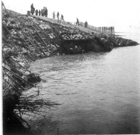
fig. 81. Herstel van de dijkval van 1955 te Scharendijke, gezien uit het oosten.
