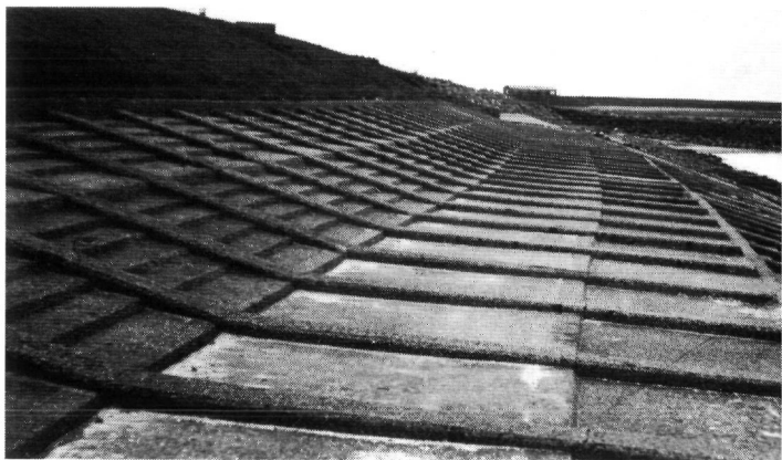
fig. 191. Trapjesbetonglooing met aansluitende bekleding van de buitenberm met betonplaten aan de Noorder-Nieuwlandpolder bij Brouwershaven.
