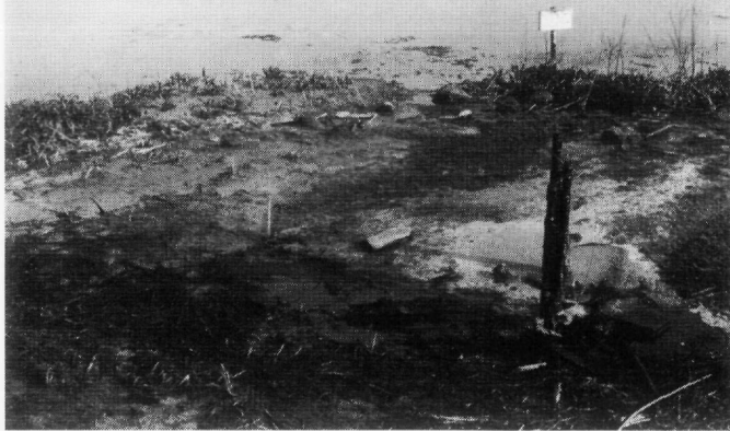
fig. 146. Peilbuizen aan de binnenzijde van de zeedijk aan de Langendijk op Schouwen. Hoogte buizen ca 1,20 m — N.A.P. Bij hoog water (N.A.P. + 1,28 m) is de waterstraal het hoogst.
