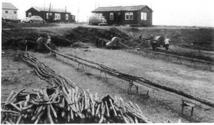
fig. 268. Machinaal wiepen spinnen voor de deltawerken te Bruinisse.
