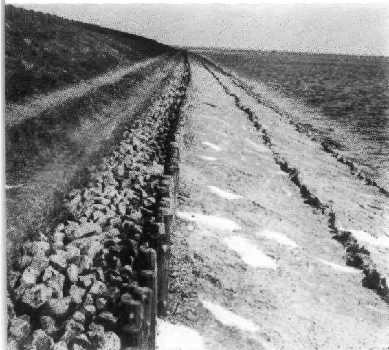
fig. 186. Glooiing van Vilvoordse steen, ingewassen met betonspecie aan de Schakerloopolder op Tholen.
