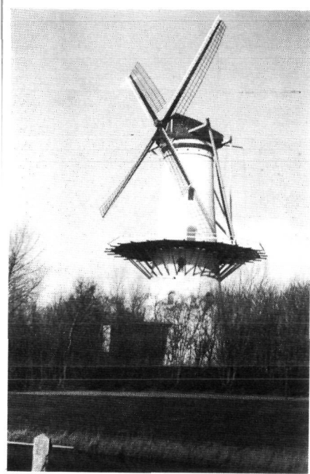
fig. 235. Baliemolen (Walmolen) „De Hoop” te Tholen. Gebouwd in 1736.
