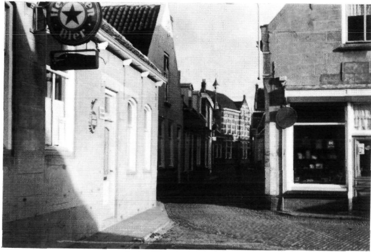
fig. 250. Traverse door Poortvliet van de v.m. Rijksweg op Tholen. De breedte tussen beide gevels is 3.10 m. De hoek van de muur bij de winkelplei aan de rechterkant is beschermd met stalen platen.
