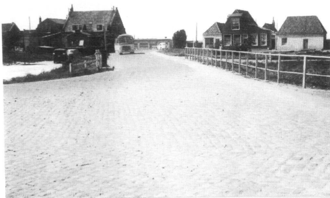
fig. 49. De Sasdam bij Zierikzee in 1962 (plaats van het vroegere „dicht- ste Sas“).
