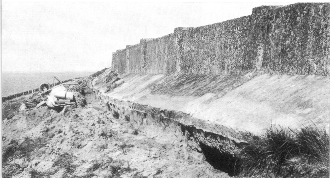
fig. 134. Ontgraving van een betonmuur aan de Razernijpolder op Tholen op 1 febr. 1953.
