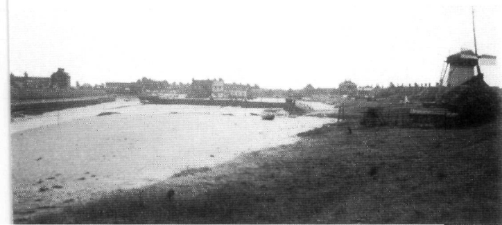
fig. 246. Overzicht van de haven van Stavenisse en omgeving.
