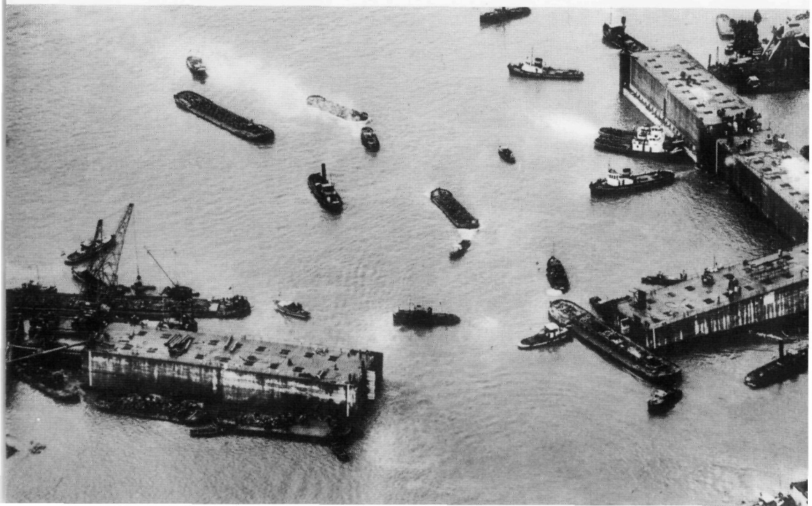
fig. 92a. De dijkdichting te Ouwerkerk op 6 november 1953. De laatste opening is nog 60 m breed.
