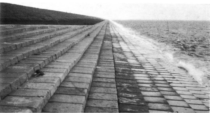
fig. 193. Betonglooing systeem „Leendertse” aan de zuidkust van Duiveland bij Ouwerkerk.
