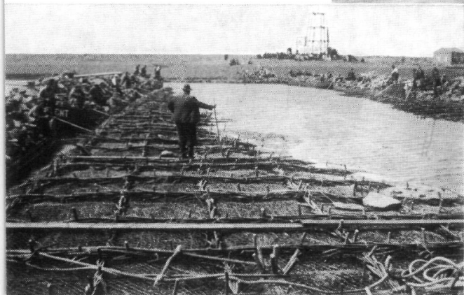
fig. 177. Het zinkstuk met roosterwerk van metaalgaas bijna gereed voor zinking.
