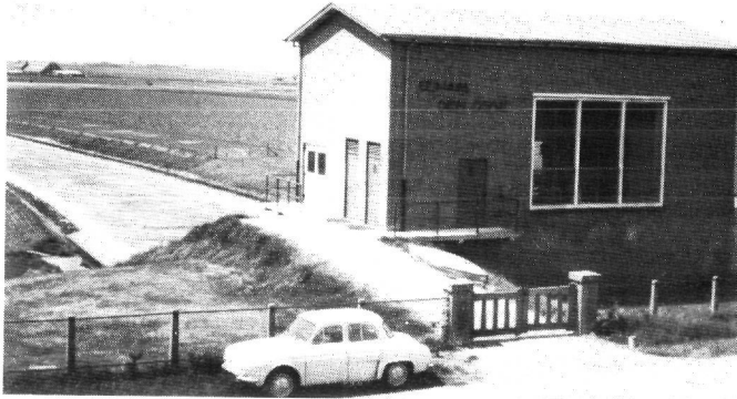
fig. 203. Het gemaal „Den Osse“ bij Brouwershaven, gereed in 1957.
