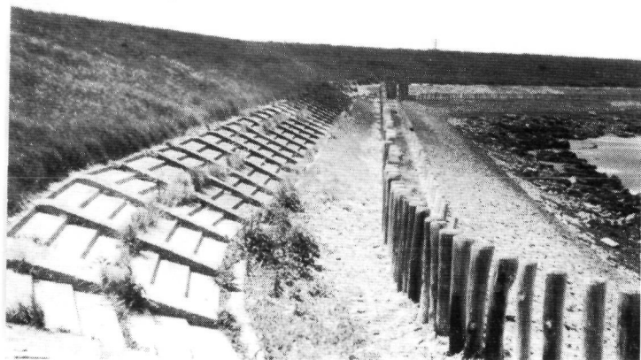
fig. 190. Trapjesbetonglooing van De Muralt aan de Groot St. Jacobspolder bij Brouwershaven.
