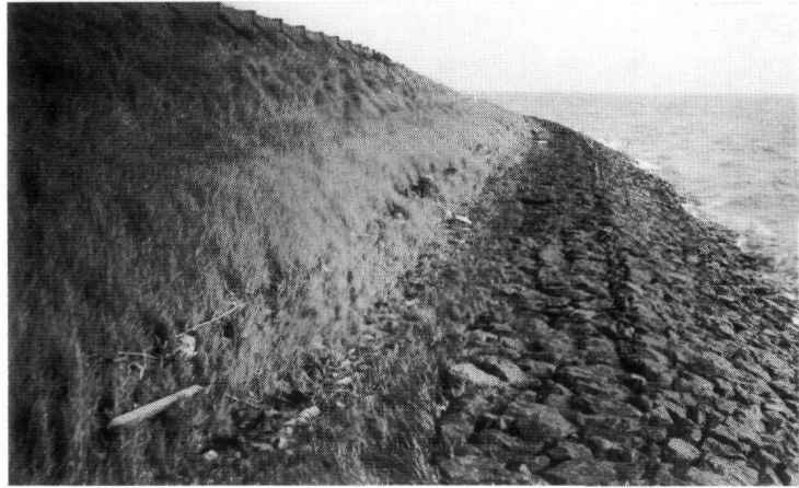
fig. 185. Zeedijk zonder buitenberm aan de zuidkust van Duiveland met glooiing van Lessinese steen.
