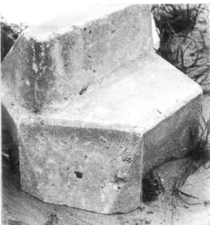
fig. 195. Betonnen glooiingsteen „Pit” aan meerdere dammen en dijken toe-gepast.
