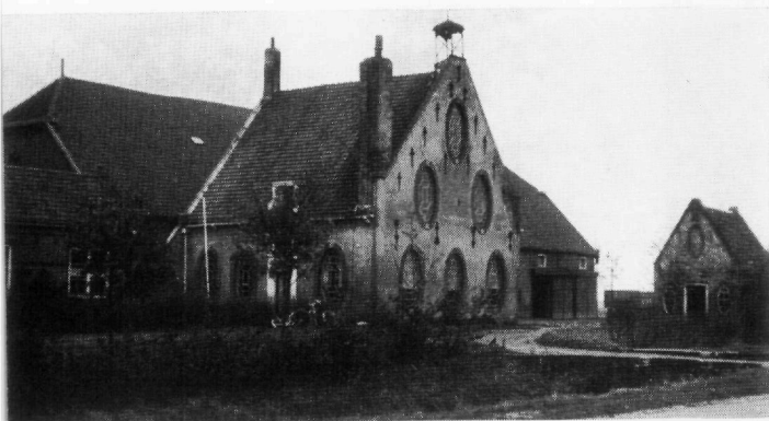
fig. 219. Hoeve „Reigersburg” met driekante schoorsteen en luiddklok bij St. Maartensdijk in de Middellandpolder op Tholen.
