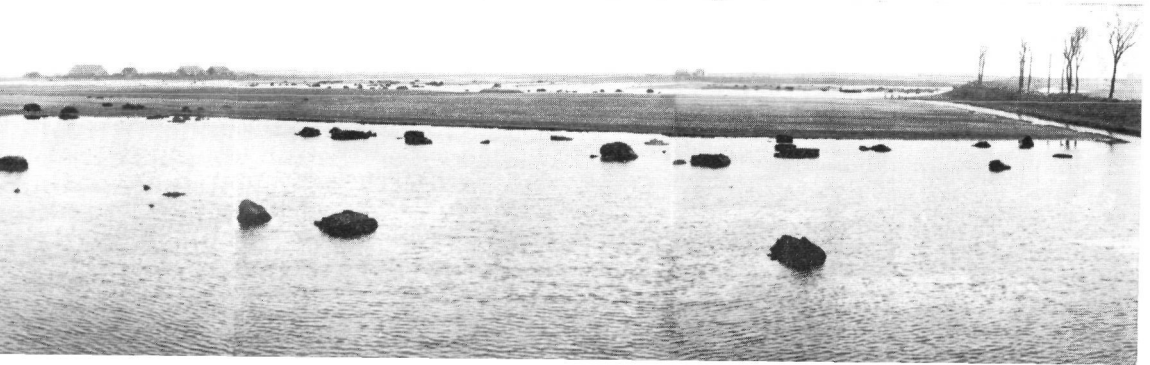
fig. 111. Overzicht van de geïnundeerde Poortvlietpolder in 1953. Rijkswaterstaat.
