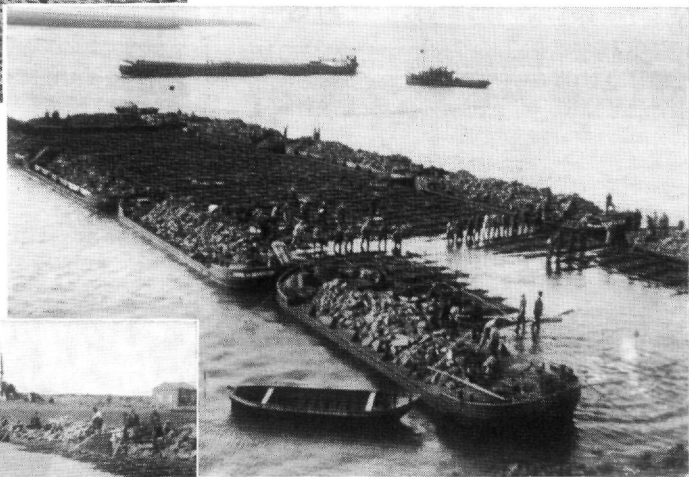
fig. 176. Begin van ballasten van het zinkstuk uit fig. 175.
