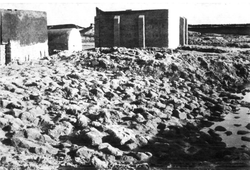
fig. 102. Begin der werkzaamheden tot dichting van een dijkdoorbraak in 1953 te Stavenisse.
