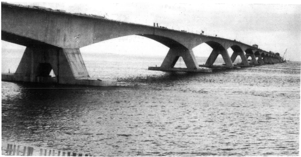
fig. 264. De Oosterscheldebrug in aanbouw.
