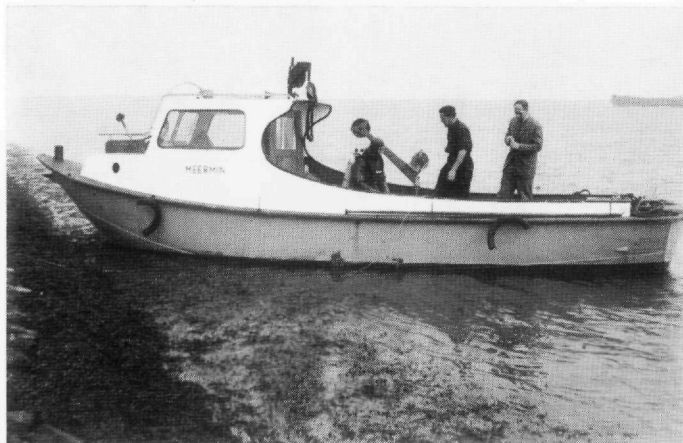
fig. 151. De peilvlet „Meermin” van het Wp. Schouwen-Duiveland (in gebruik als werkschip voor duikwerkzaamheden).
