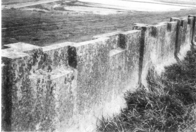
fig. 133. Betonmuur „de Muralt” met vertanding te Stavenisse.
