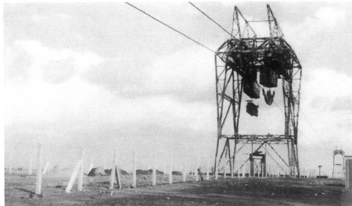
fig. 272. De kabelbaan gereed. Enkele gondels in bedrijf. Gezien vanaf de Grevelingendam bij Bruinisse.
