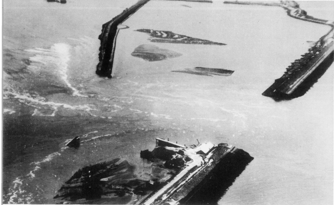
fig. 92. De situatie op 8 februari 1953 van de dijkdoorbraak te Schelphoek aan de zuidkust van Schouwen. Dijkbres 200 m breed, 20 m diep.
