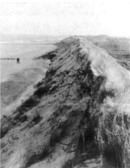
fig. 168. Weggeslagen duinvoet tussen de strandhoofden 3 en 4 aan het Noorderstrand van Schouwen bij de storm van 30 dec. 1904.
