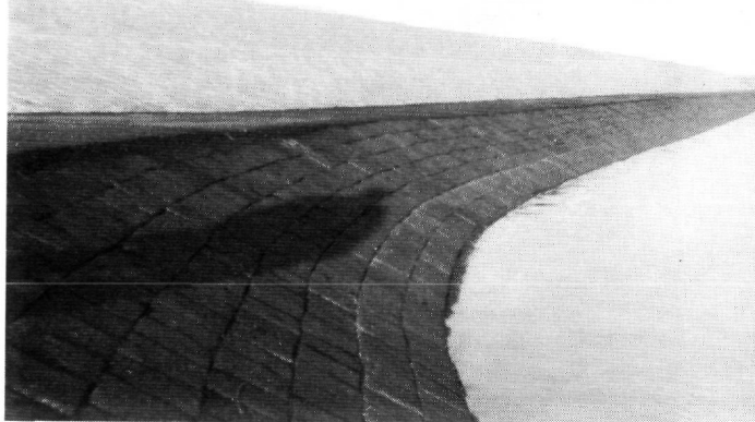
fig. 188. Mansfeld koperslablokkenglooing aan de havendam van de deltaxerkehaven bij Den Osse aan de noordkust van Schouwen.
