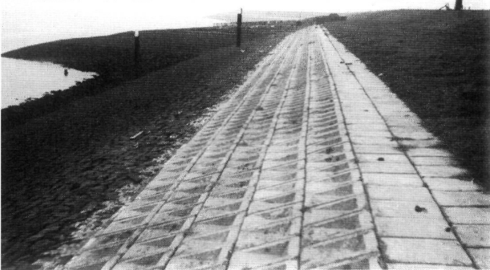
fig. 194. Betonglooiing systeem Haringman aan de cal. Scherpenissepolder op Tholen.
