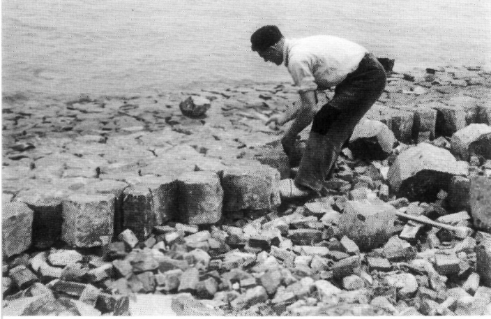
fig. 184. Het zetten van een basaltglooiing langs het Zijpe te Bruinisse.
