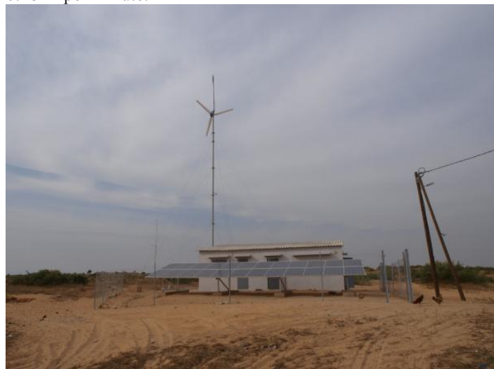
(d) Hybrid wind-PV systems [40]
