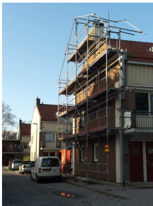
Figuur 23 Sagenbuurt fase 2 – isolatie zijkant woningen (Foto auteur)
