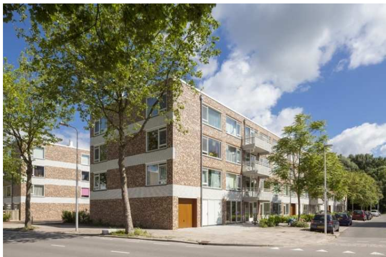
Figuur 11 Resultaat renovatie Overvecht 3,5 hoog (Linders, N.d.)
