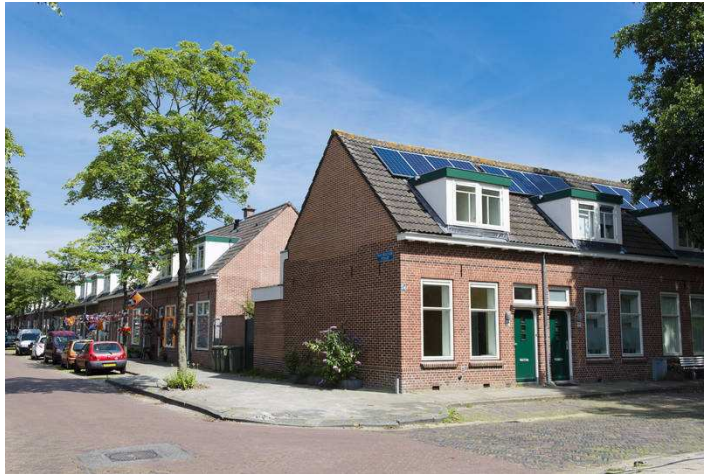
Figuur 32 Woningen Amsterdamse buurt na de renovatie (Elan Wonen, 2014a)
