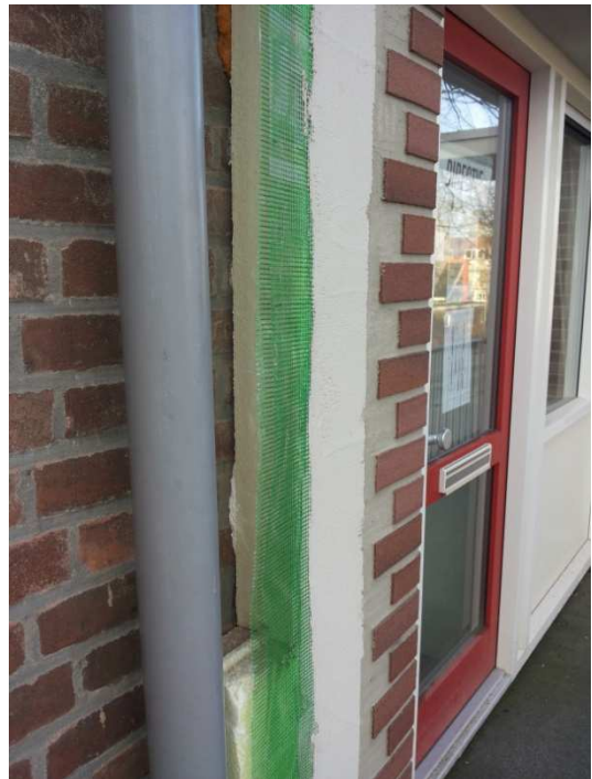
Figuur 24 Sagenbuurt fase 2 – extra isolatiepakket (Foto auteur)
