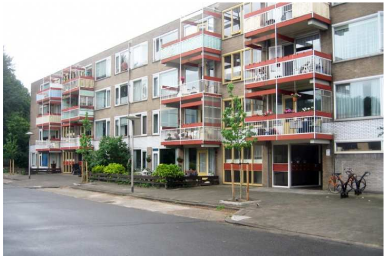
Figuur 10 Woningen overvecht 3,5 hoog voorafgaand aan de renovatie (Linders, N.d.)
