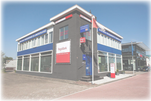
Case 1 Office building Krimpen aan den IJssel 1
