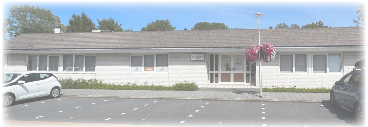
Case 5 Office building Krimpen aan den IJssel 2
