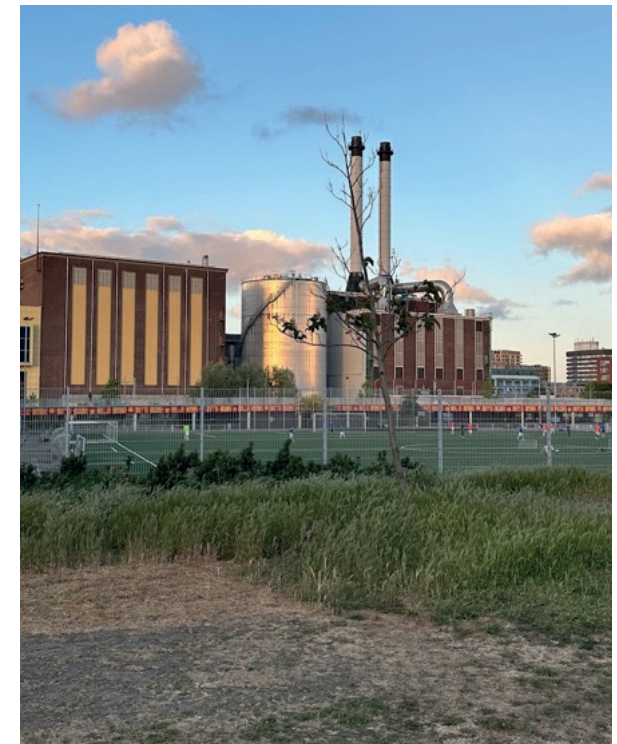
Foto van de huidige energiecentrale vanuit het (sport)park
