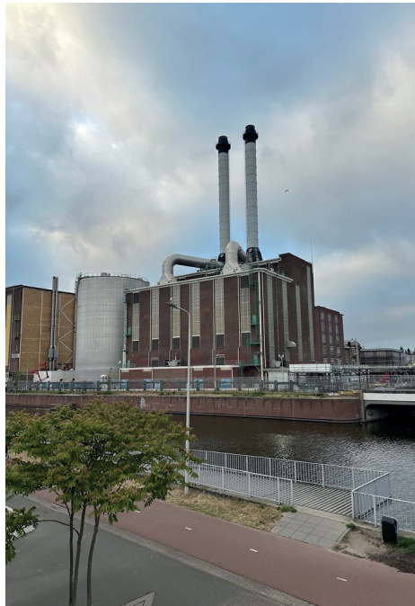
Het exterieur van de Energiecentrale
