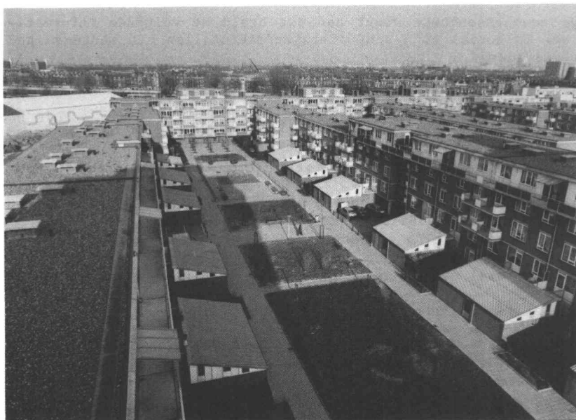
Zicht op een van de binnenterreinen met bergingen van de tandwoningen.
