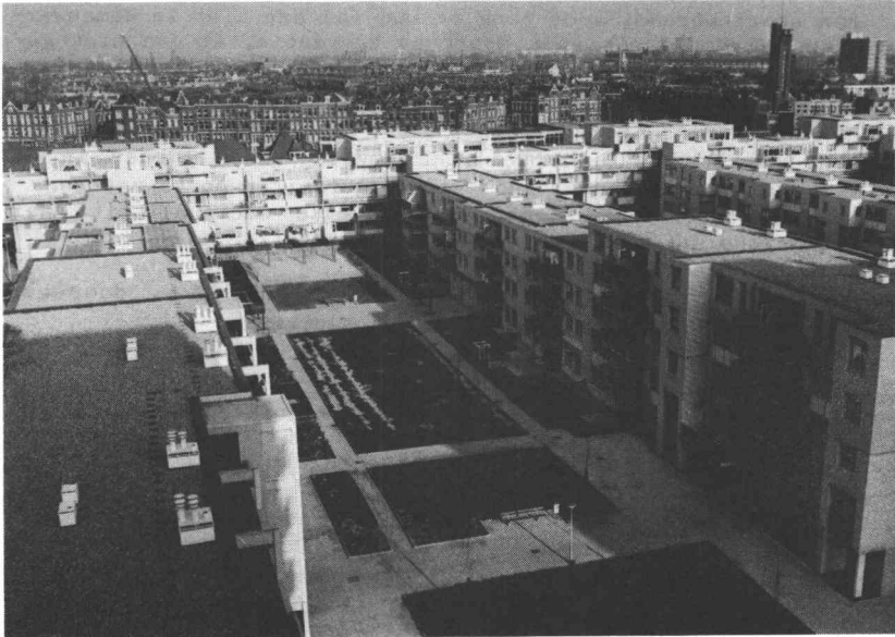
Zicht op een van de sober ingerichte binnenterreinen.
