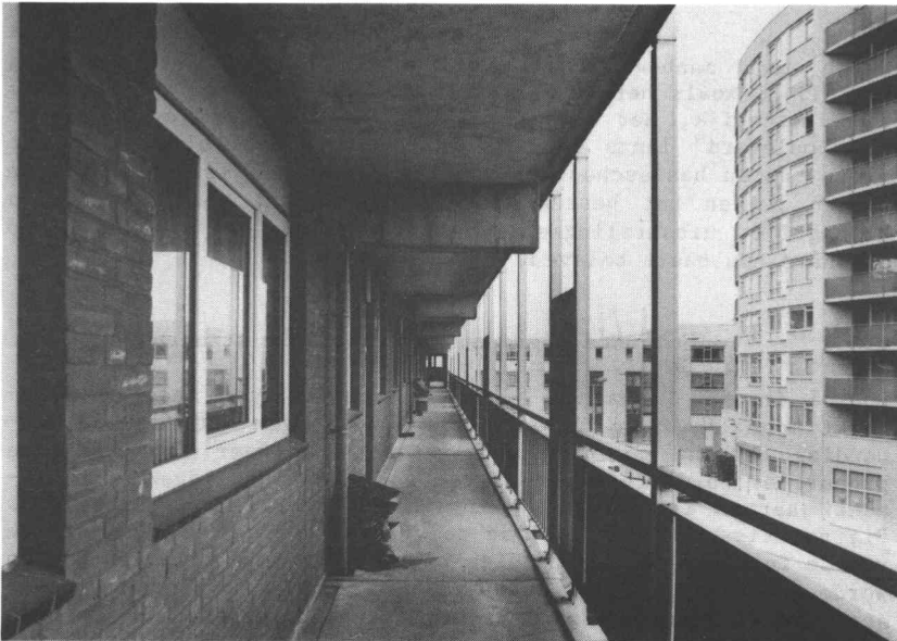
Galerij ter ontsluiting van een groot aantal woningen aan de Westkousdijk.
