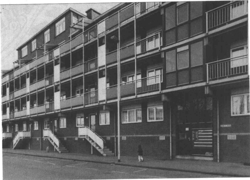
De rugwoningen aan de Pelgrimsstraat, deels ontsloten via een eigen opgang en deels via galerijen.
