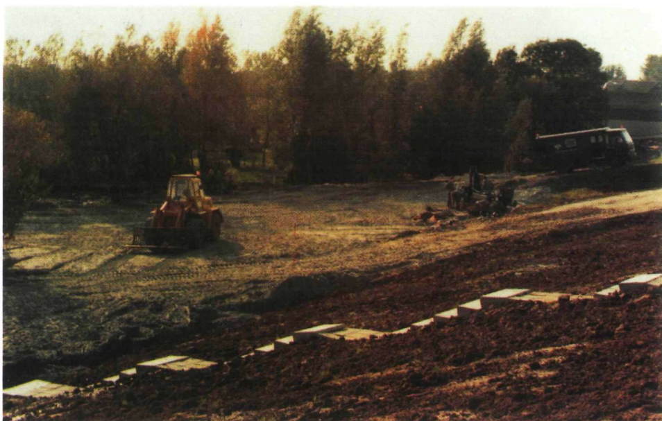
Zandaanvulling ter voorkoming van verdere afschuiving (Streefkerk)
