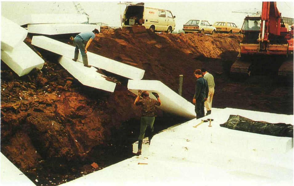
Toepassing polystyreenblokken Streefkerk-West
