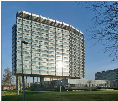
FIGUUR 32 VOORMALIG HOOFDKANTOOR PHILIPS EINDHOVEN BRON: WWW.DEGELDERLANDER.NL
