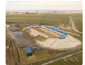
6 Eemdijk Test Site
