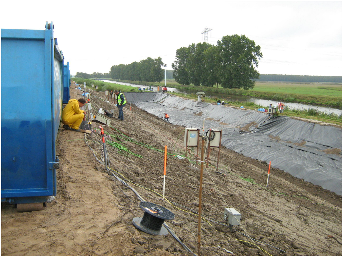
Figuur 3.4 Aansluiten van de instrumenten enkele dagen voor aanvang van de proef (buitentalud proefdijk).
