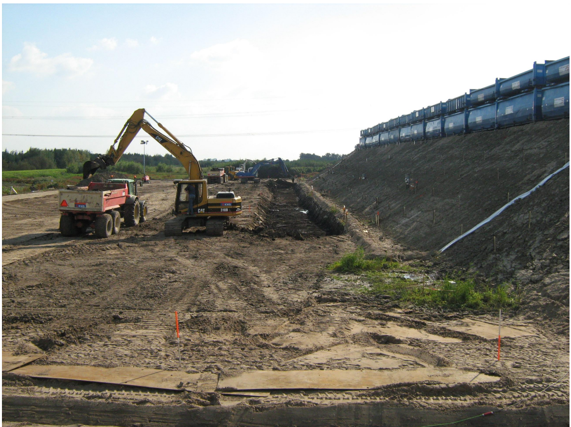
Figuur 3.6 Ondiepe ontgraving.
