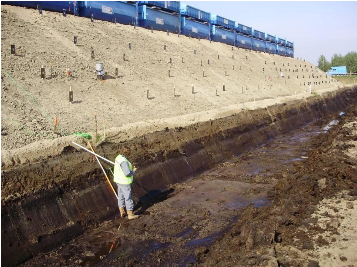
Figuur 3.7 Ontgraving tot op de diepe zandlaag – plaatsing van waterspanningsmeter.
