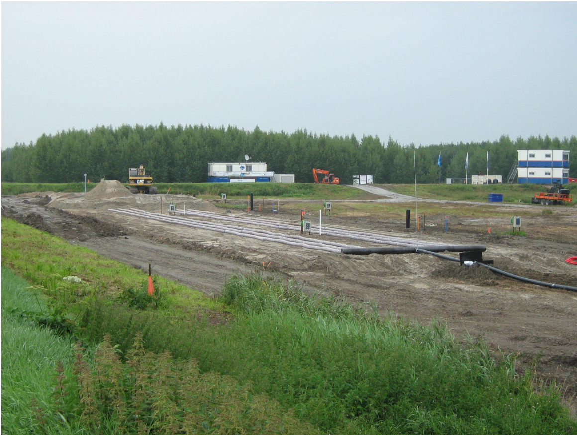
Figuur 3.3 Macrostabiliteitsdijk in aanbouw (18 augustus 2008 – alle foto's van Deltares tenzij anders vermeld).
