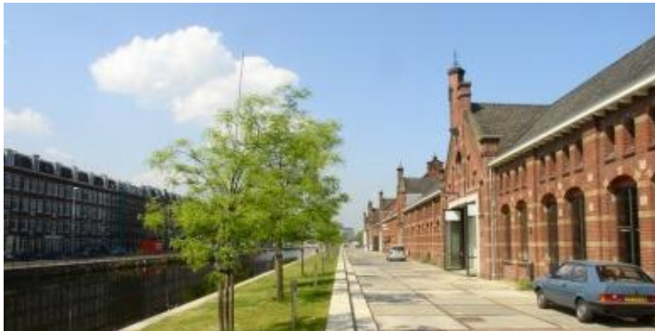
8.5 Aanzicht zuiveringshal Westergasfabriek Amsterdam
