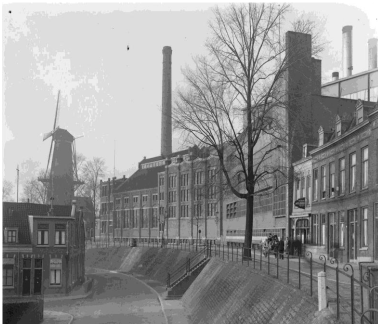
8.2 Elektriciteitscentrale, Dordrecht 1908 – 1928 Afbeelding: Jonkman en Klinkhamer
