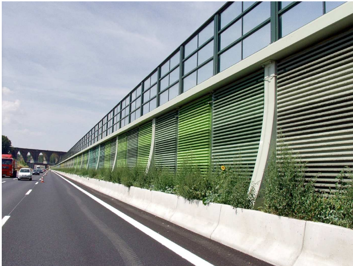
Afb. 3.1.2c: Poreus betonnen geluidswand langs de Bundesautobahn 4 ter hoogte van Chemnitz (Liadur, 2008).
