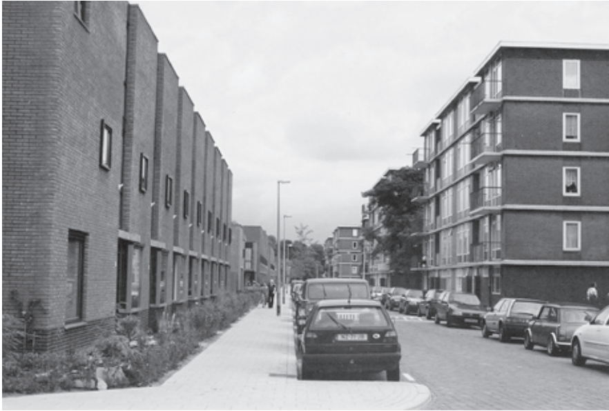
Nieuwbouw in Hoograven, waar eerst portiek-etagewoningen stonden.
