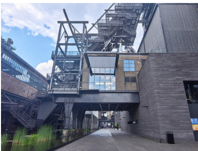
图 3 登上高炉的台阶以及高炉脚下的功能性附属建筑（图片来源：作者拍摄）
