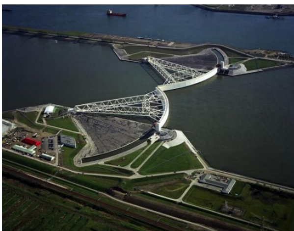
Fig S8. Maeslant barrier (image by Rijkswaterstaat)
