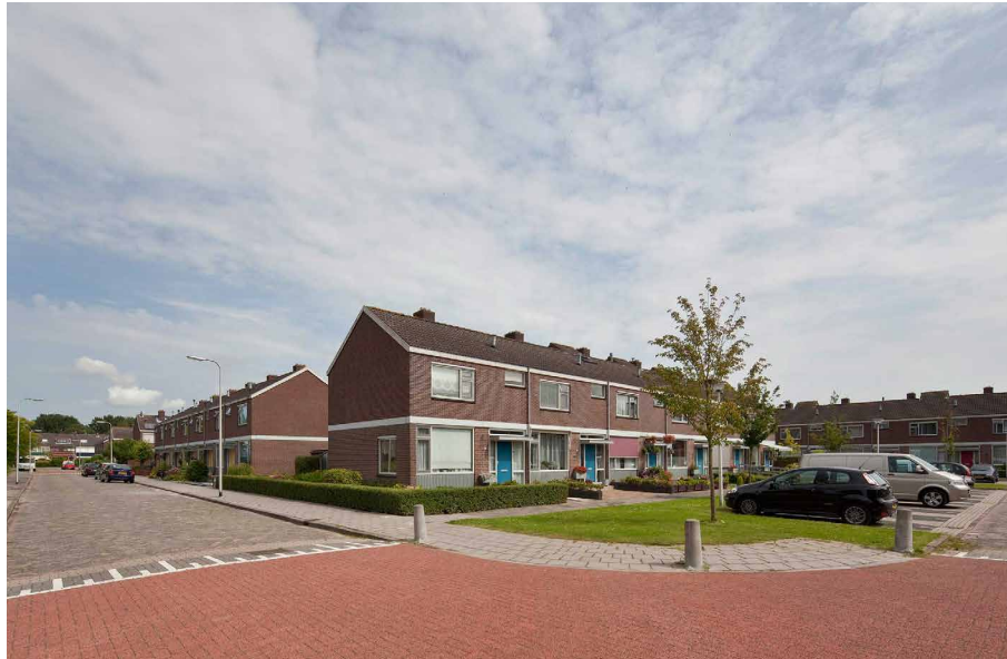
FIGUUR 2.7 Renovatieproject Krimpen aan den IJssel (bron: Energiesprong | Frank Hanswijk)
