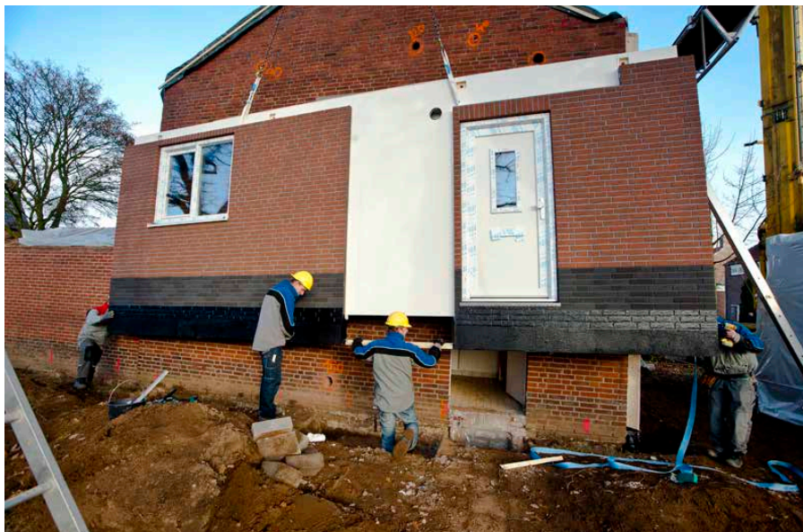
FIGUUR 2.19 Een nieuwe gevel wordt geplaatst voor de prototype van VolkerWessels in Melick (bron: Vereniging De Stroomversnelling | VolkerWessels | WonenLimburg)
