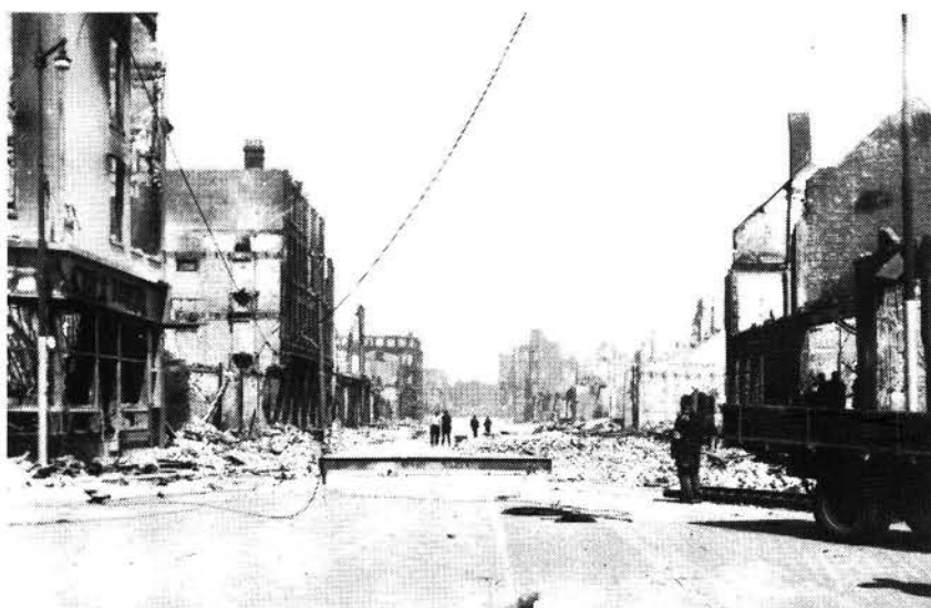
1. De Jonker Fransstraat na het bombardement.
