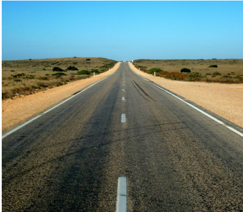
Afbeelding 53 Spanningsboog, Eyre Highway, Australië
