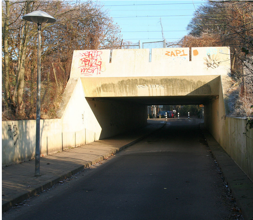
Afbeelding 11 Fietstunnel laan van Soestbergen
