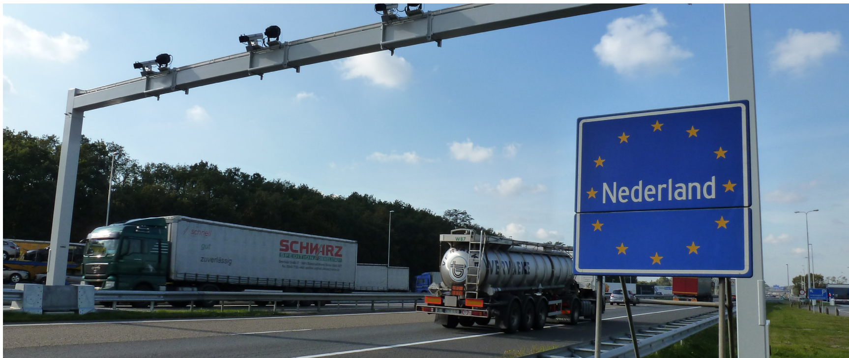
Afbeelding 20 Camerabewaking grensovergang Venlo
