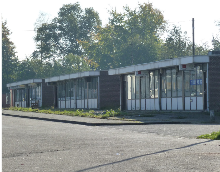
Afbeelding 18 Vervallen bebouwing, grensovergang Venlo – Duisburg
