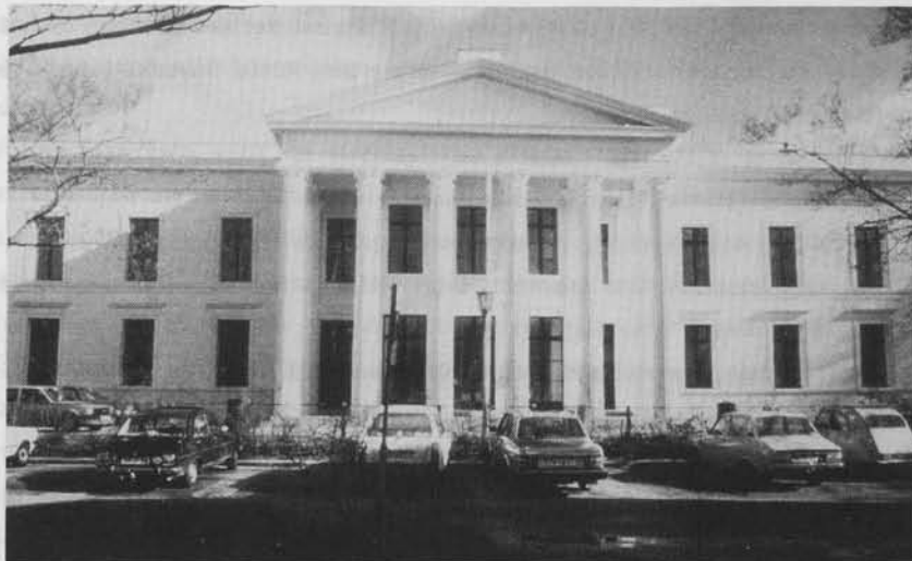
Figuur 17. De afdeling Informatievoorziening van de Rijks Planologische Dienst is gehuisvest in het voormalige Gerechtsgebouw in Zwolle.
