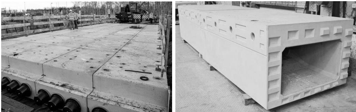
Figure 35. Structural elements and connections (Kamper Nieuws, 2018; Van Hattum en Blankevoort, 2019)
