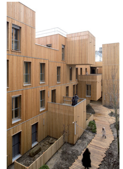
Tete in L'air Paris, KOZ Architectes, 2013
