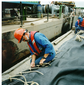
Placing a Geocontainer (Photos Rijkswaterstaat, DWW)
