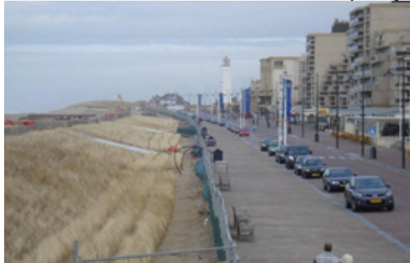
Dijk in Duin Noordwijk
