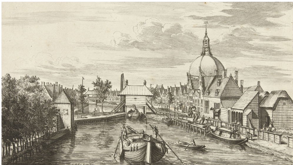
▲ Figuur 8 De Leidschendam omstreeks 1678 (Coenraet Decker, Rijksmuseum Amsterdam). Door tegenwerking van vooral Gouda werd hier pas in 1648 een bescheiden verlaat (soort schutsluis) aangelegd. In 1886-87 werd het verlaat vervangen door de huidige veel grotere sluis.
