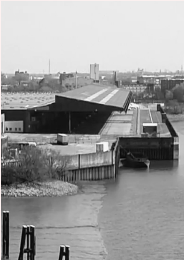
Old roof Überseezentrum
