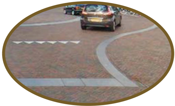
Gebakken klinkers Brede beton banden op zelfde niveau
