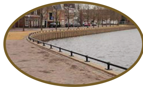
Gemetselde kademuur Doorrijbeveiliging stalen stang
