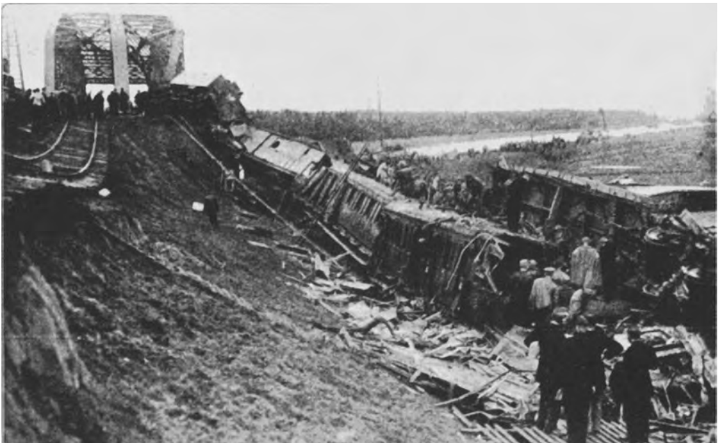
Figuur 2 | 13 september 1918, treinongeval bij Weesp door bezwijking van de spoordijk bij het Merwedekanaal. (Bron: Spoorwegmuseum. )
