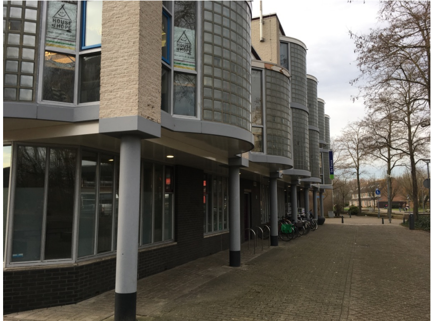
Wijkgebouw de Focus in de Beverwaard.
