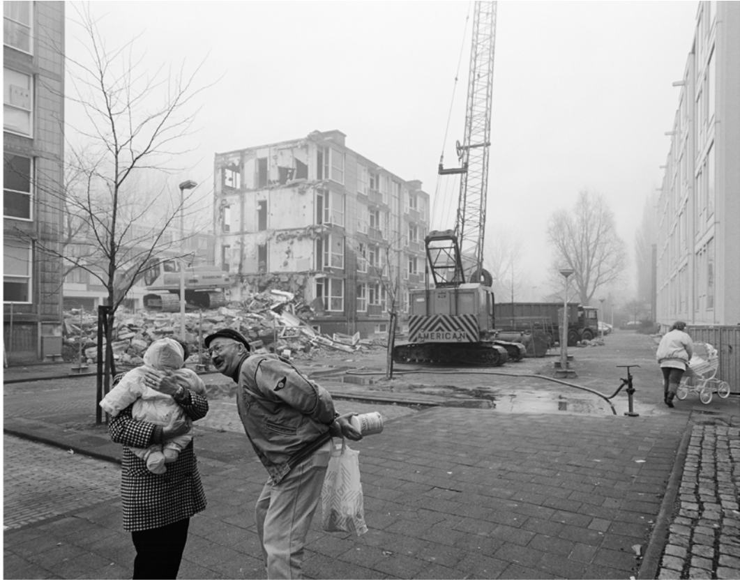
FIGUUR 4.3 Sloop in de Horsten Bron: Joop Reyngoud
