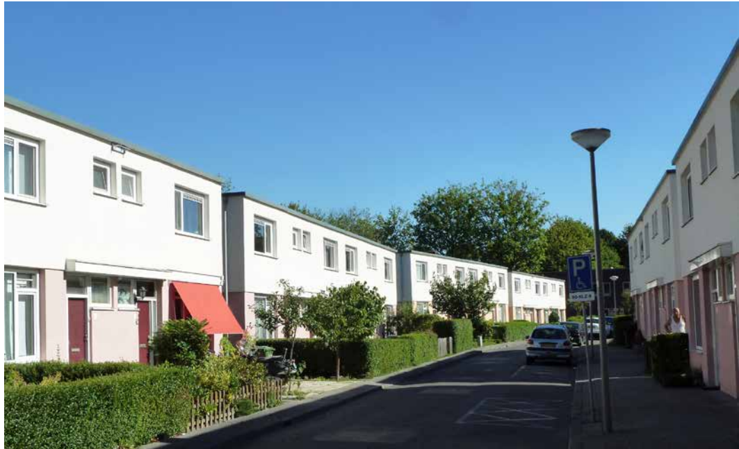
FIGUUR 7.6 Controle in de Roze Kampen
