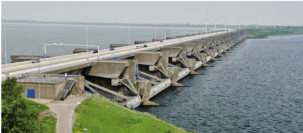
Figure 3.2 The Haringvliet sluices. From Rijkswaterstaat (2011a)
