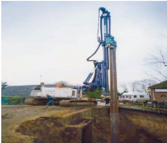
Figuur 47. Herstel van een duiker met damwanden.
