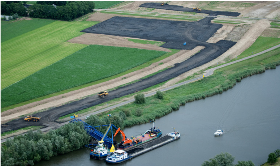
Figuur 19. Aanleg terpen in de Overdiepse polder. Bron: Rijkswaterstaat.
