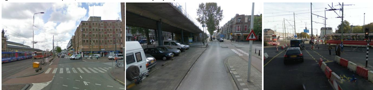
Figuur 5.8 Het Stationsplein, het Schenkviaduct en het Rijswijkseplein
