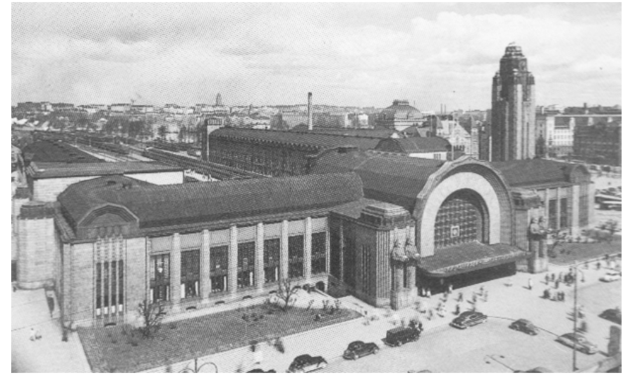
16. Treinstation Helsinki Saarinen - Helsinki (1904-1919)
