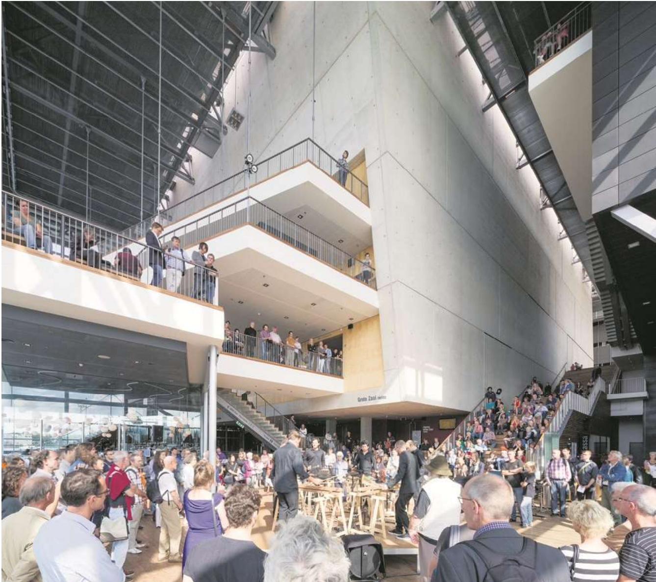
3XN, Muziekgebouw aan 't IJ, Amsterdam NL (2005)
